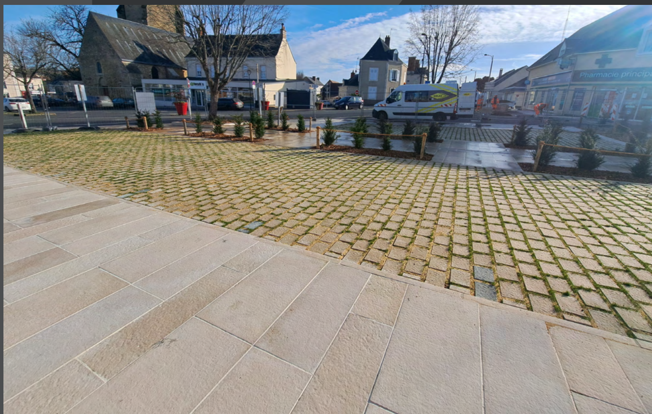
Connerré (72) MOE : Feuille à feuille
