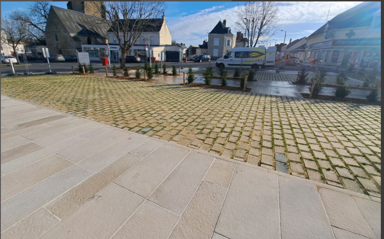
Connerré (72) MOE : Feuille à feuille
